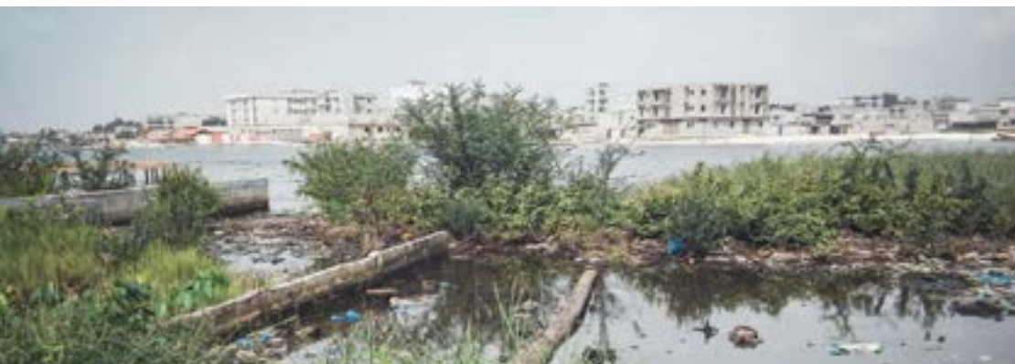
Aménagement du secteur riverain en Abidjan
